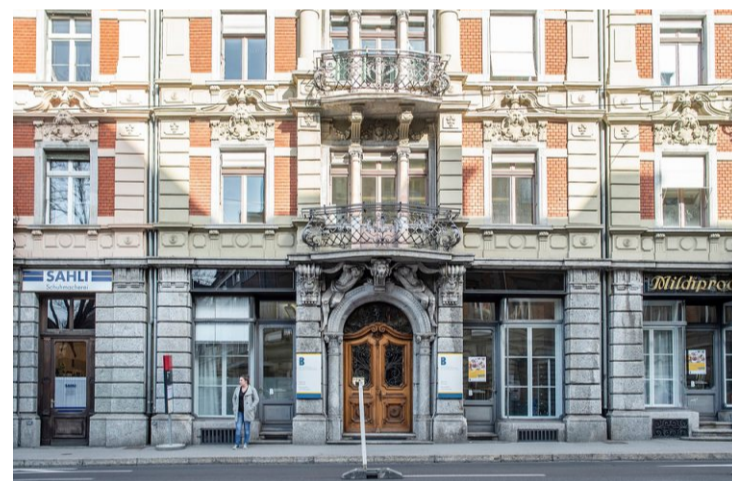
Dieser Bau am Falkenplatz, wo die Berner Fachhochschule Büros hat, zeigt Elemente von Jugendstil-Häusern. Foto: Franziska Rothenbühler
